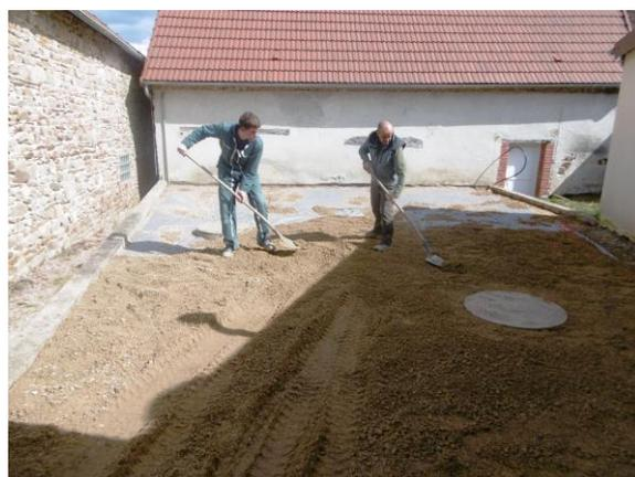
Après décaissement, mise en place d'un géotextile et fourniture de 0/25, une couche de gravier de 6/10 a été étendue sur toute la surface.
