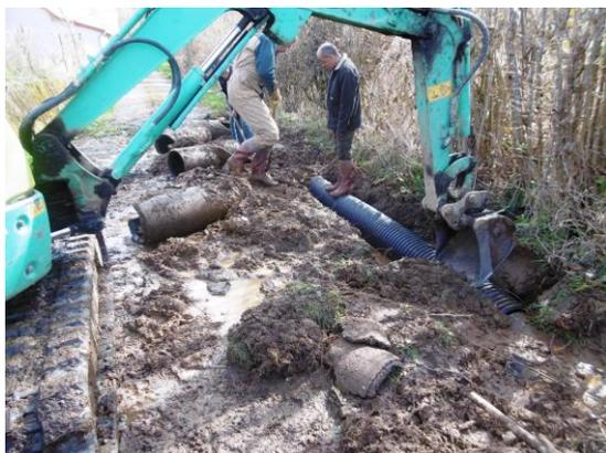
L'abondance des pluies de l'hiver et le mauvais état des canalisations des eaux de pluies ont fini par provoquer une **obturation complète** du réseau, et en conséquence, d'importantes inondations.
