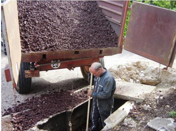
Avec le temps, le filtre de pouzzolane, à travers lequel étaient épurées les eaux usées des logements de l'ancienne école de Boënat, a fini par se colmater.
