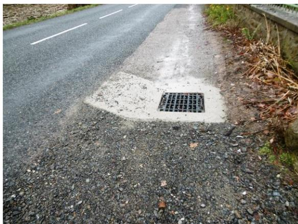
Suite à la réfection, par le Département, de la RD 998 et à un relèvement de la chaussée, les eaux, par temps d'orage, s'infiltraient dans la cour d'un riverain.
