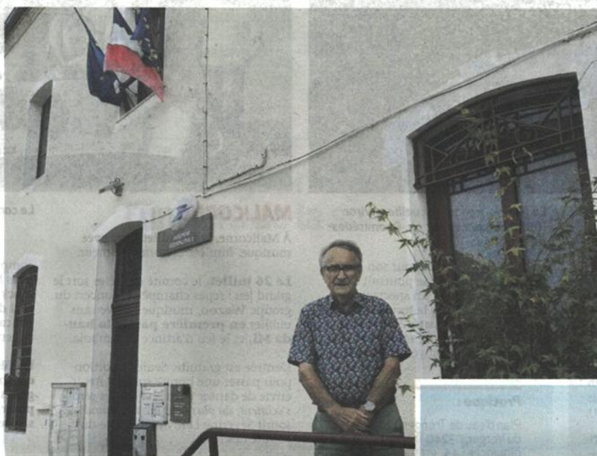
Maurice Deschamps, maire, peut être fier du travail accompli, avec la restauration de la mairie, de l'église, de l'école et de la salle polyvalente !
